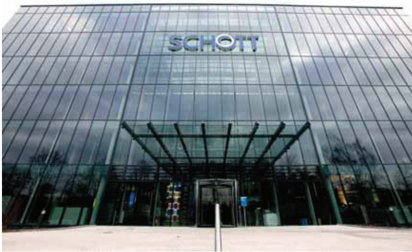
Die modernisierte Konzernzentrale der SCHOTT AG in Mainz.
