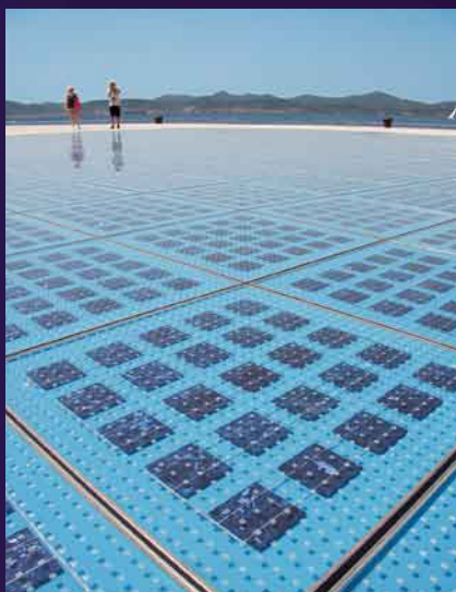
Tagsüber leuchten die Module nicht, sie erzeugen stattdessen Strom, der ins Netz eingespeist wird
