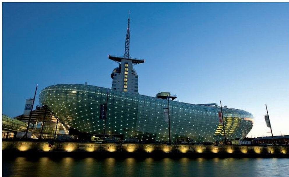
Außenansicht Klimahaus® Bremerhaven 8° Ost, im Hintergrund das im März 2008 eröffnete ATLANTIC Hotel SAIL City
